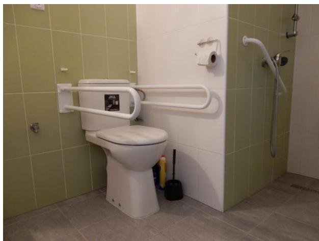
Koupelna po rekonstrukci.
